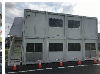
▲ユニットハウスの採用
