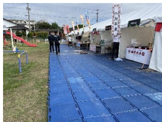
▲土・芝生面への下地養生敷設
