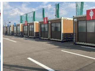
▲水洗トイレの整備
