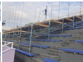
▲システム材やリース部材の有効活用
