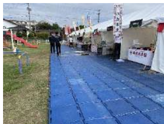
▲土・芝生面への下地養生敷設
