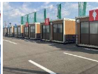
▲水洗トイレの整備
