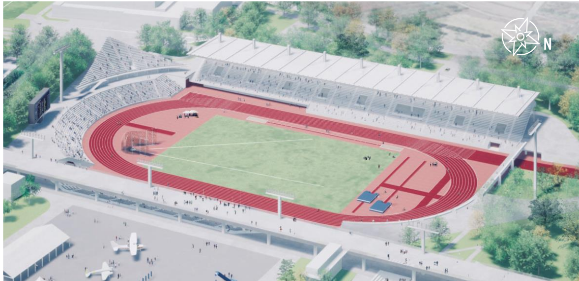
既存の陸上競技場を除却した上で、新たな陸上競技場を整備（R 8年度から供用開始予定）
